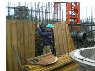
【コンクリートを流し込むための型枠を組み立てる作業の様子】
