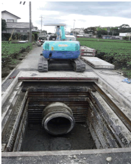
立坑完成状況（既設管Φ1,000）
