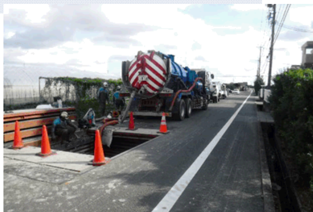
管更生工法の前処理 (管内汚泥の吸引作業)
