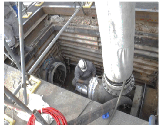
道路に設置した立杭内での作業状況 （既設管を切断し、新しい管の材料を挿入）
