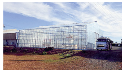
地中熱利用システム導入ハウス
