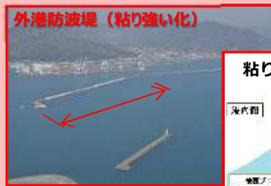
港湾施設の津波対策 (防波堤の粘り強い化)
