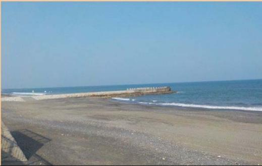
突堤整備により砂浜が復元しつつある
