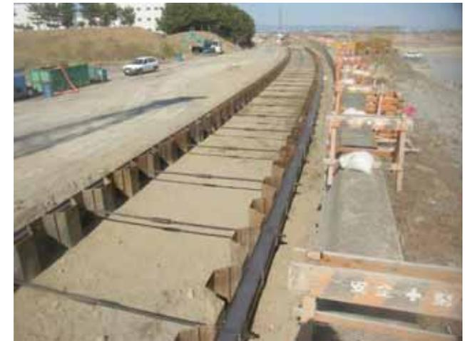
堤防法肩に施工した鋼矢板を接続することで、必要な天端高を確保します
