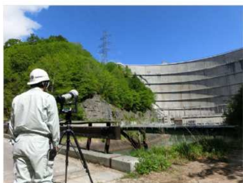
ダム (堤体・洪水吐など)
