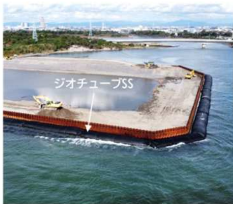
静岡県馬込川地震・高潮対策工事(仮締切工)
