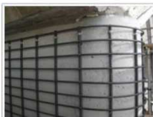
補強鉄筋組立工 (step3)
