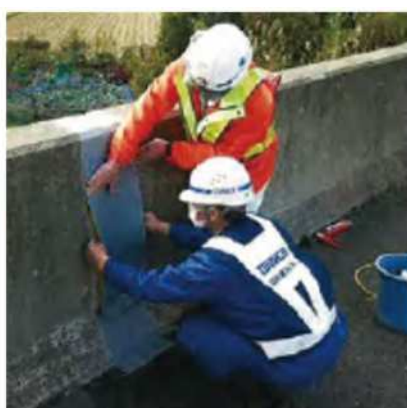
壁高欄遊間目地への応用
