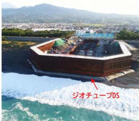
沼津河川国道事務所沼川新放水路建設工事
