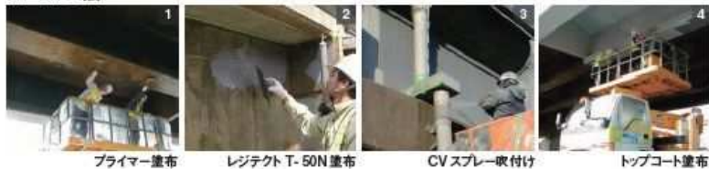
プライマー塗布
