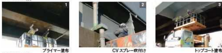
プライマー塗布
