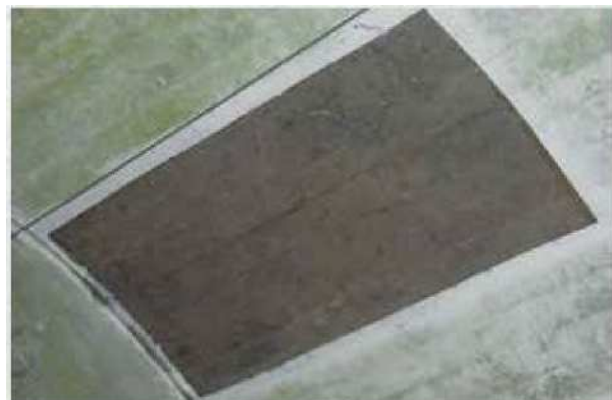
貼付け後は透明となり、躯体状況が確認できます
