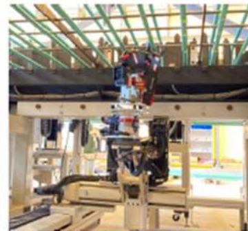
下筋結束用ロボット
