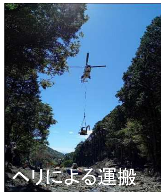
無人化BH施工(堰堤の除石)
