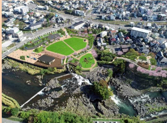
【鮎壺公園整備事業 —長泉町HPより—】
