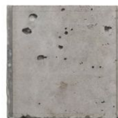
プロコンパネル未使用
