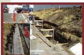
基礎コンクリートの施工
