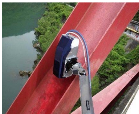
トラス橋の斜材の計測
