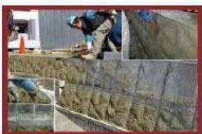
コンクリートの打設
