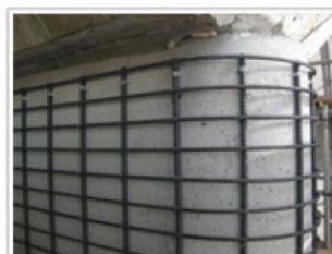
補強鉄筋組立工 (step3)
