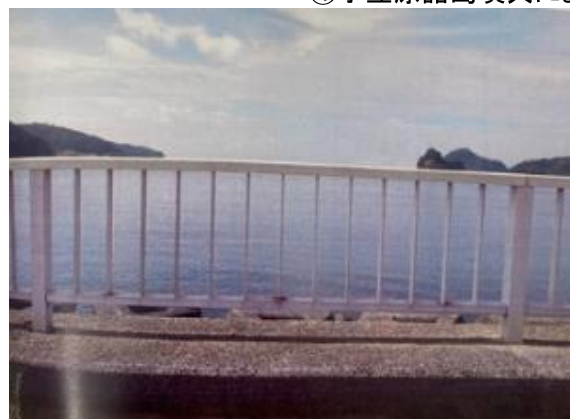
⑤下田港転落防止策の修繕
