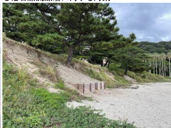
⑥木柵施工
