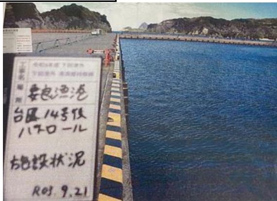
①台風後のパトロール状況
