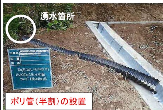
土側溝の設置
