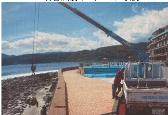
③漂着物の撤去作業状況
