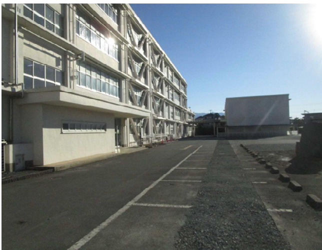
埋設配管施工
