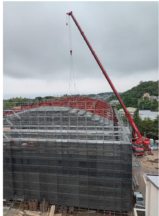
屋根鉄骨梁 施工状況
