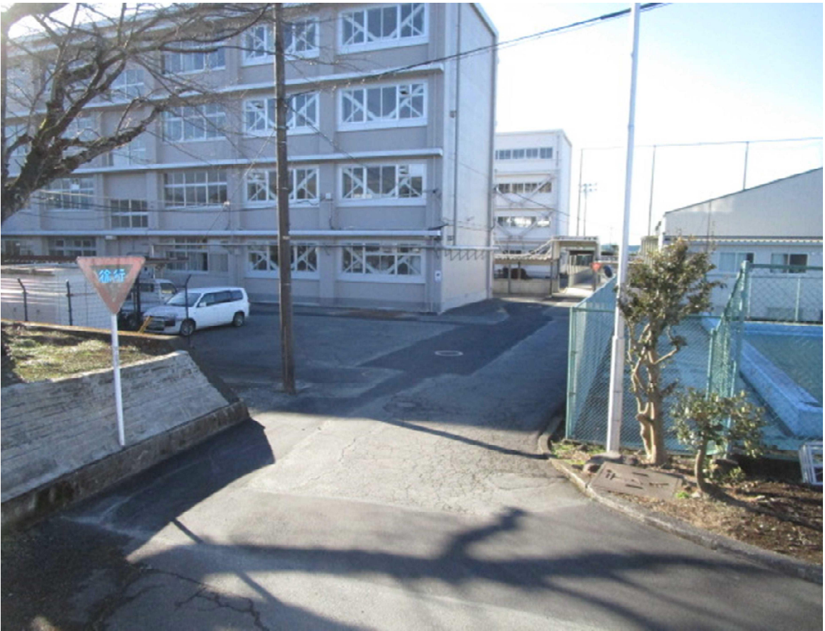
埋設配管施工
