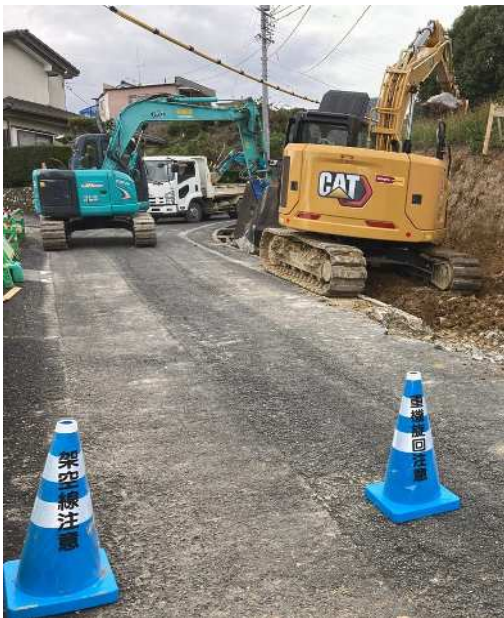
コーンで重機と人の行動範囲を分離及び注意喚起内容表示 → オペ・作業員の共通認識
