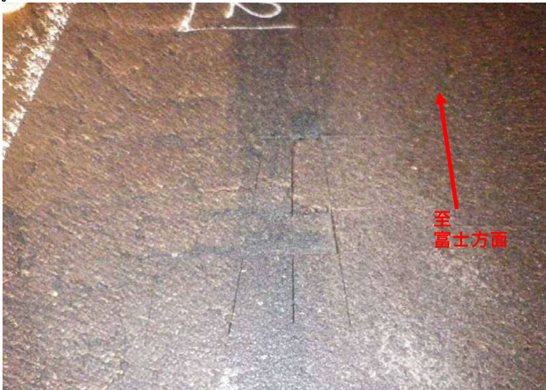
舗装版切断状況
