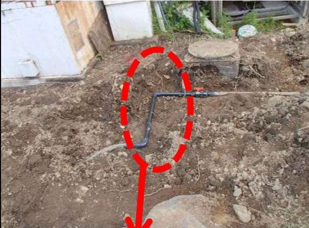
破損復旧箇所
