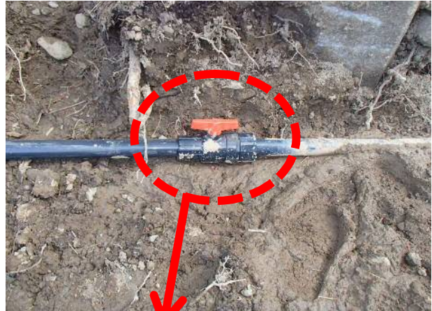
保守整備用に止水バルブを設置
