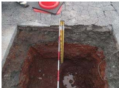
埋設管深さ確認(GL-1.0m付近)
