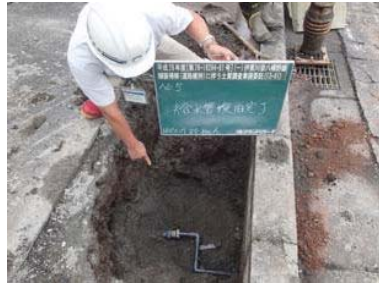
給水管復旧完了(歩道部)・伊東市杉山氏立会
