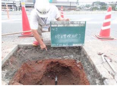
給水管復旧完了(道路部)・伊東市杉山氏立会
