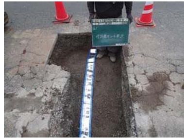
埋設標示シート敷設
