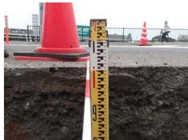
埋設管深さ確認(GL-1.0m付近)
