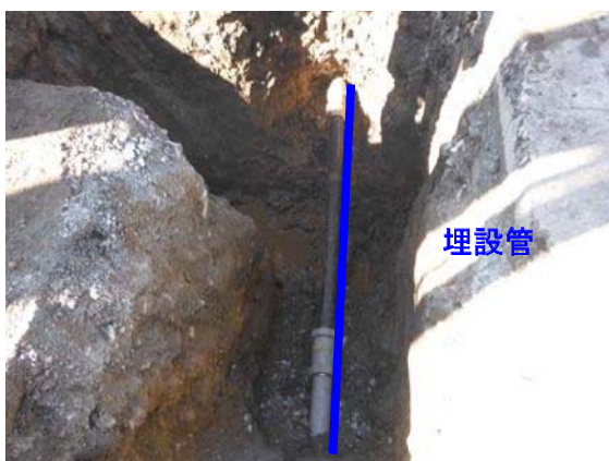
写真9:管の復旧状況
