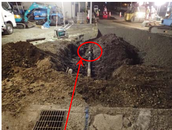
水道管復旧完了
