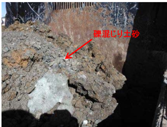
写真5:掘削採取した上水道管の埋戻し土
