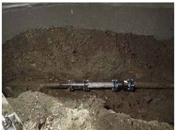
水道管復旧完了
