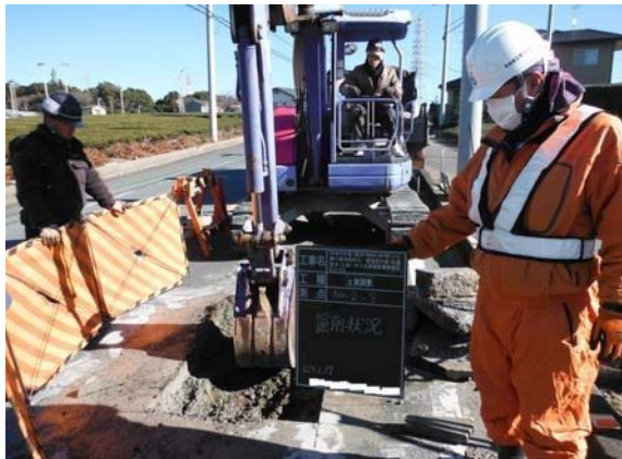
写真1: 事故直前の掘削状況
