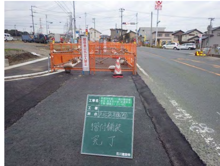
浜松袋井線乗入部擦り付け完了
