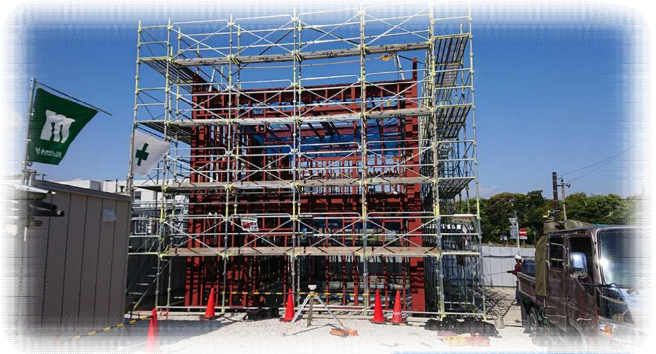
鉄骨工事の様子(4月)
