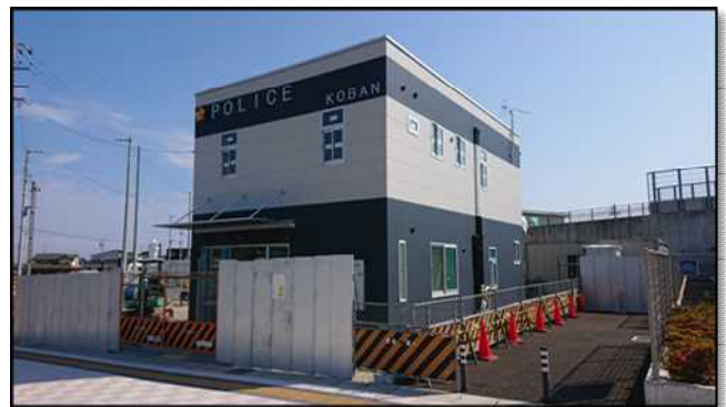
完成間近の御厨交番(6月)
