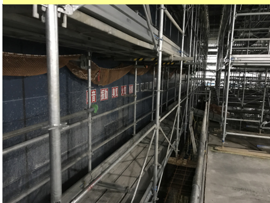
↓ 既存と増築の接続部分
