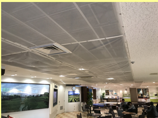
↑ 既存建物の天井
