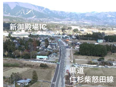
新御殿場IC 県道 仁杉柴怒田線 <御殿場市>
