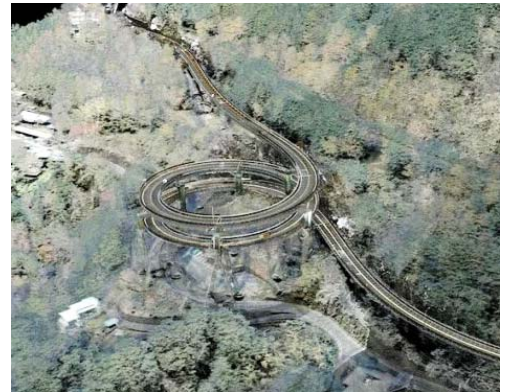
(国) 414号（七滝高架橋）
