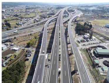
新東名高速道路（御殿場JCT） <御殿場市>
