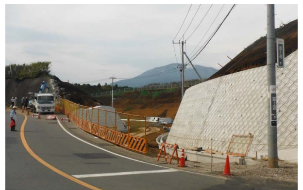
施工状況(愛鷹上り市道付替工事)
