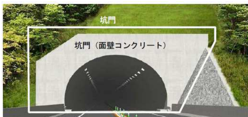
図 1.2 点検対象箇所（トンネル坑口部） 1)
