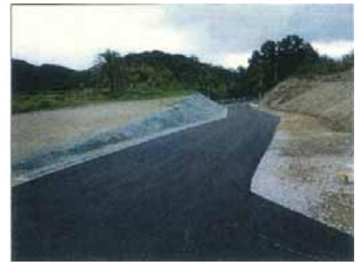
工業用地内 管理用通路整備
