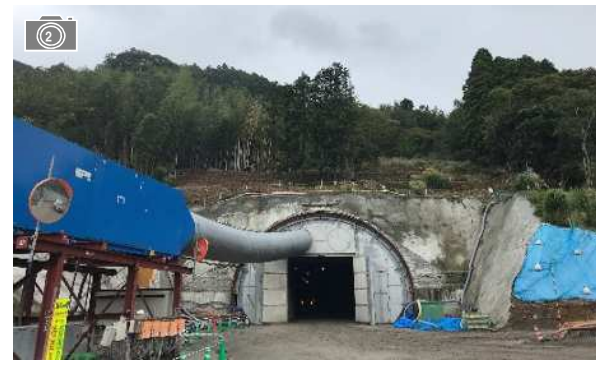
河津トンネル(仮称)坑門状況(R1.12撮影)
