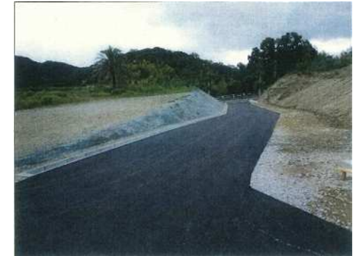
工業用地内 管理用通路整備
