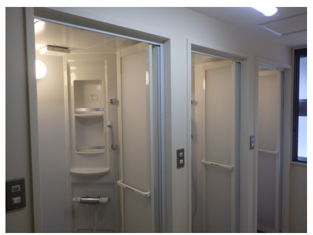
更衣室(ユニットシャワー設置)
