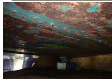
床版（補強材の再劣化）
