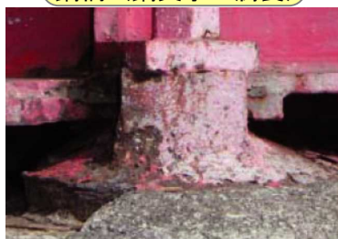
鋼橋（鋼支承の腐食）
