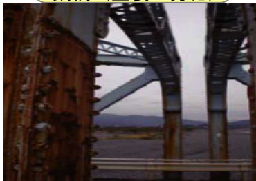
鋼橋（鋼支承の腐食）
