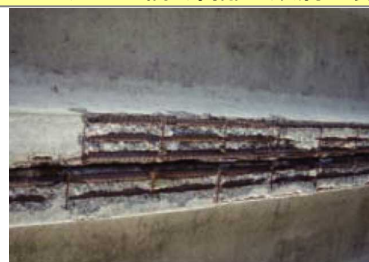
床版（補強材の再劣化）
