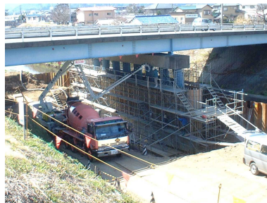
コンクリート打設状況
