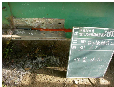
作業状況（当て板設置）
