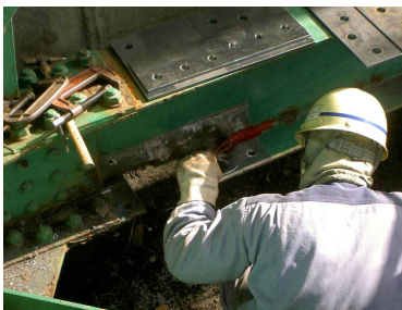
作業状況（錆落とし、切断）
