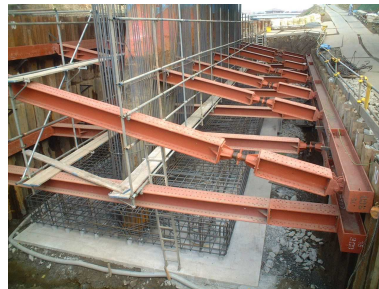
橋脚の配筋状況（躯体部）
