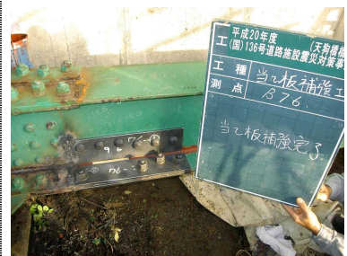
作業状況（ボルト固定）
