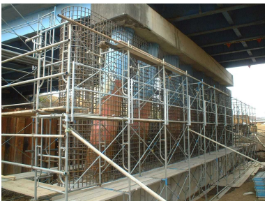
橋脚の配筋状況（橋脚部）
