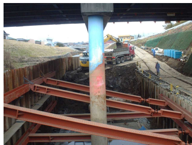
仮縮切の施工状況
