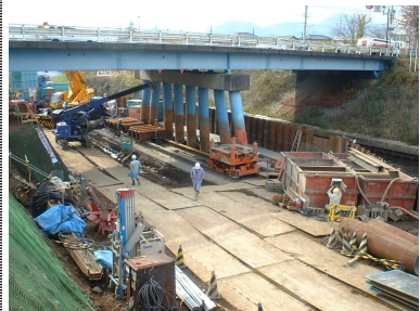
増し杭（スペース21工法）の施工状況
