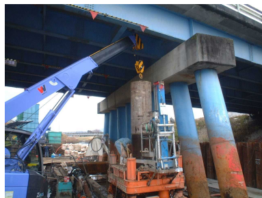
増し杭（スペース21工法）の施工状況
