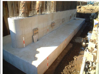
躯体部の施工状況
