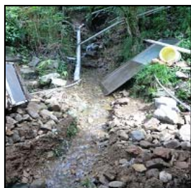
①須原地区の浸水被害
