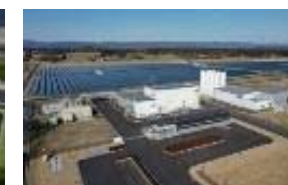
再エネを利用した水素製造施設 (出典) NEDO
