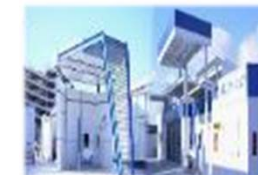
水素ステーション (出典) 豊通エア・リキードハイドロジェンエナジー
