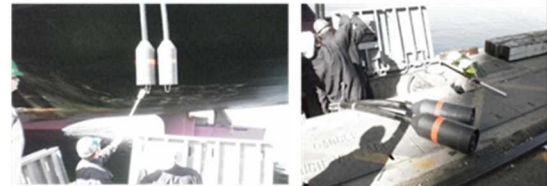
ロサンゼルス港における陸上電力供給の実施状況
