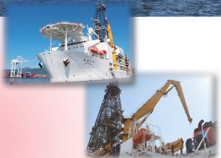
地球深部探査船「ちきゅう」の巨大なデリック(掘削やぐら)とクレーン
