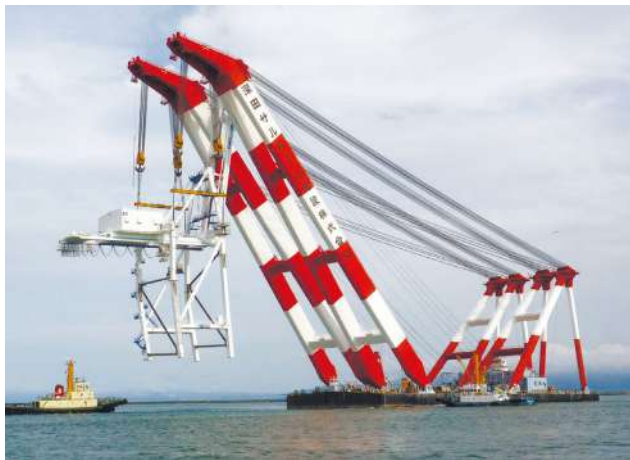
4号機を吊り上げた起重機船
