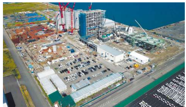
「御前崎港バイオマス発電所」建設状況(令和4年9月30日撮影)
