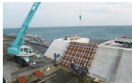
御前崎港防波堤整備状況 (写真提供:清水港湾事務所)
