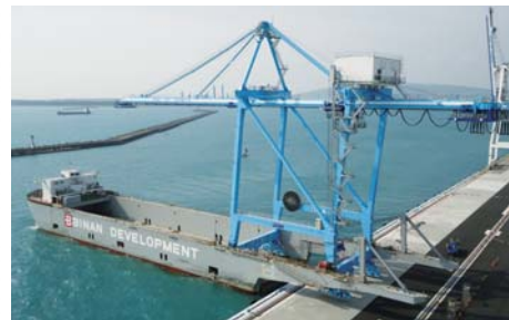
新興津地区コンテナクレーン整備状況
