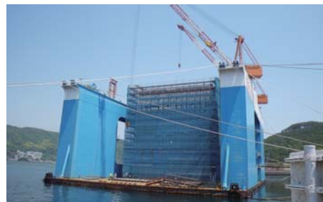
下田港防波堤整備状況 (写真提供:清水港湾事務所)
