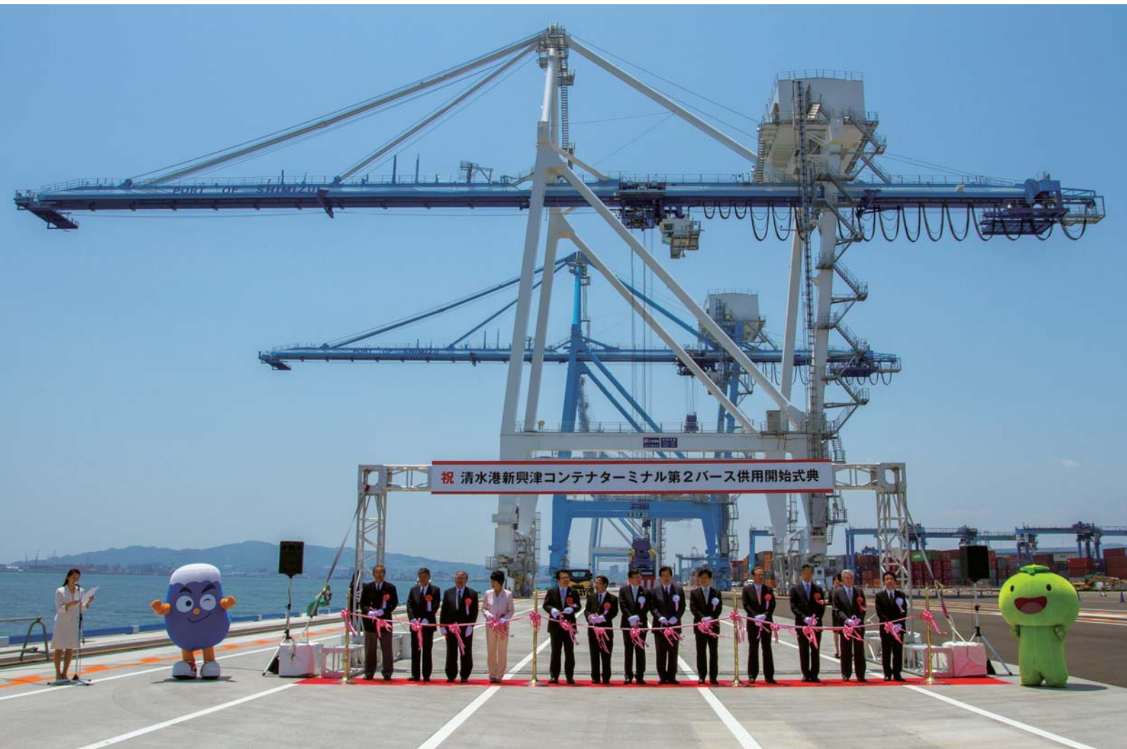
平成25年5月25日に供用開始した清水港新興津コンテナターミナル第2バース
