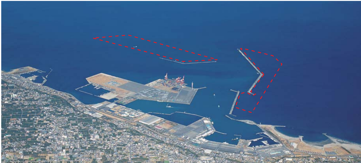
御前崎港の再生可能エネルギーゾーン
