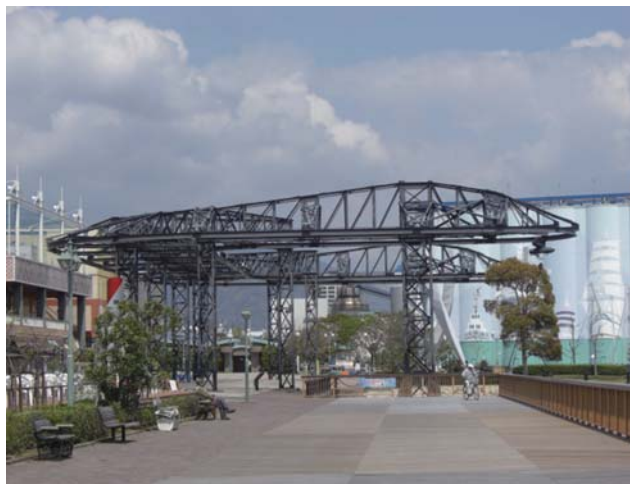
昭和3年建造のテルファークレーンをモニュメントとして再利用 (マリンパーク)
