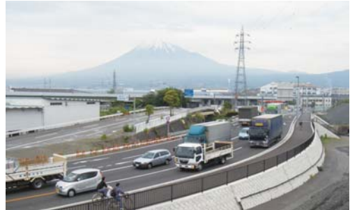
臨港道路7号線の整備状況(田子の浦橋架け替え状況)
