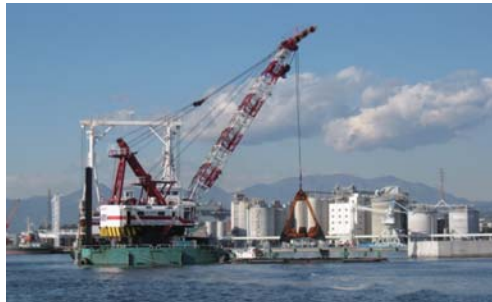
田子の浦港泊地浚渫状況(写真提供:清水港湾事務所)
