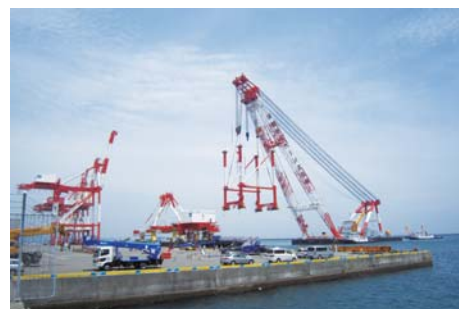
御前崎港コンテナクレーン整備状況
