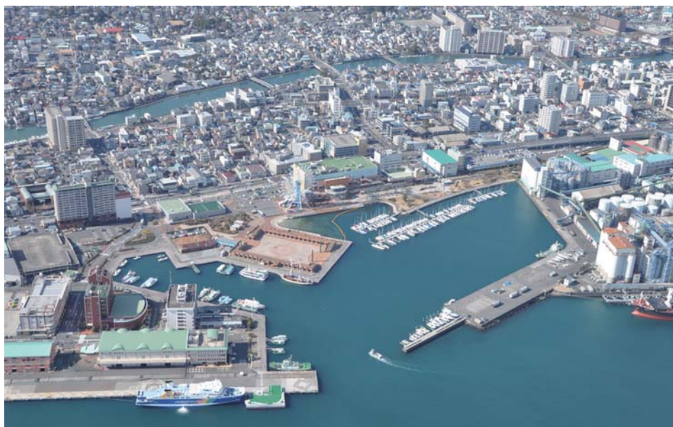
清水港日の出地区(平成24年2月撮影)
