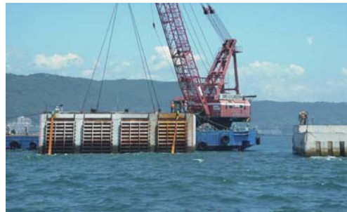
下田港津波対策(写真提供:清水港湾事務所)
