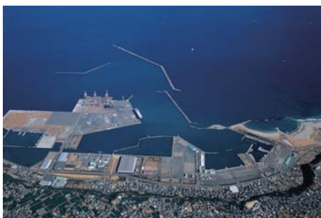
御前崎港全景(写真提供:清水港湾事務所)
