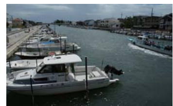
浜名港物揚場整備状況
