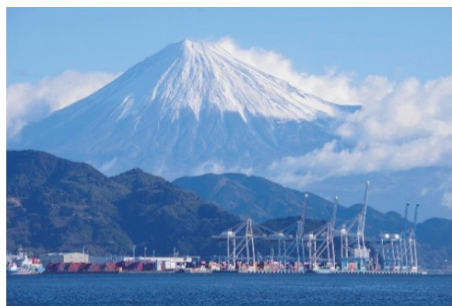
23列積みの大型船に対応可能な免震コンテナクレーン（右から3基目）
