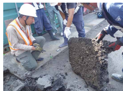
アスファルトを掘り起こしての駆除作業
