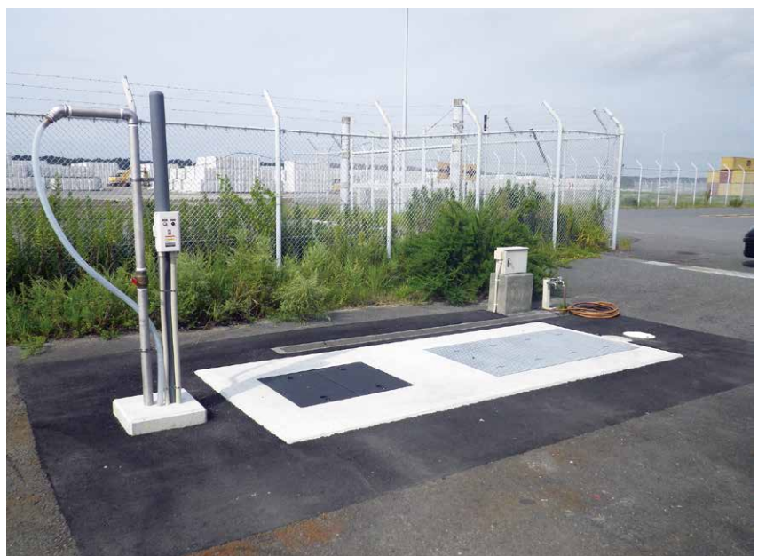
完成したコンテナ洗浄施設
