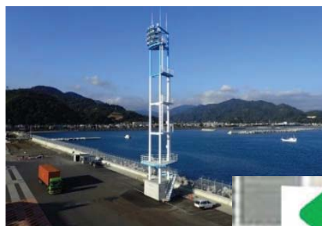
照明塔兼用津波避難施設 （新興津埠頭）
