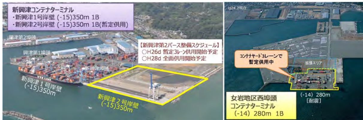
図 3-24 駿河湾港のコンテナターミナルの整備状況
