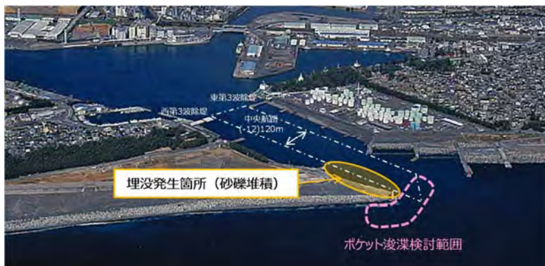
図 4-32 田子の浦港中央航路の埋没対策実施状況
