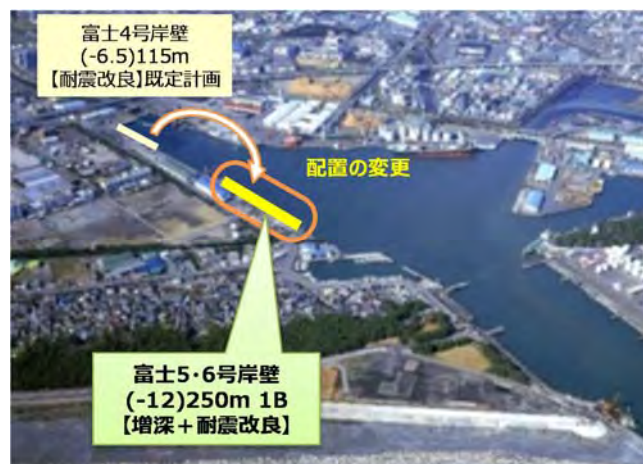
図 6-32 田子の浦港における緊急物資等輸送用耐震強化岸壁の配置変更計画
