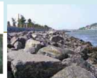
自然石を使った傾斜護岸
