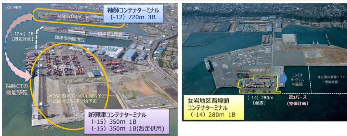
図 1-8 清水港・御前崎港のコンテナターミナル整備状況
