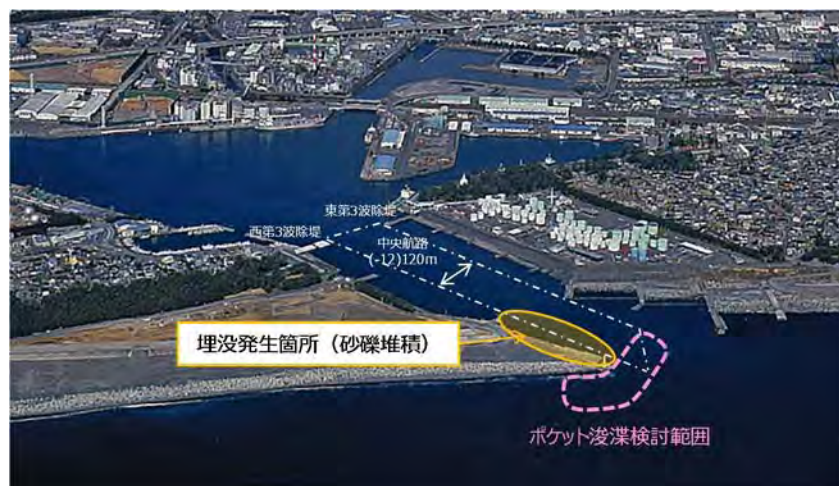
図 3-11 田子の浦港中央航路の埋没対策実施状況
