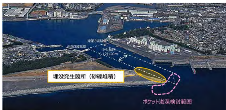
図 3-32 田子の浦港中央航路の埋没対策実施状況
