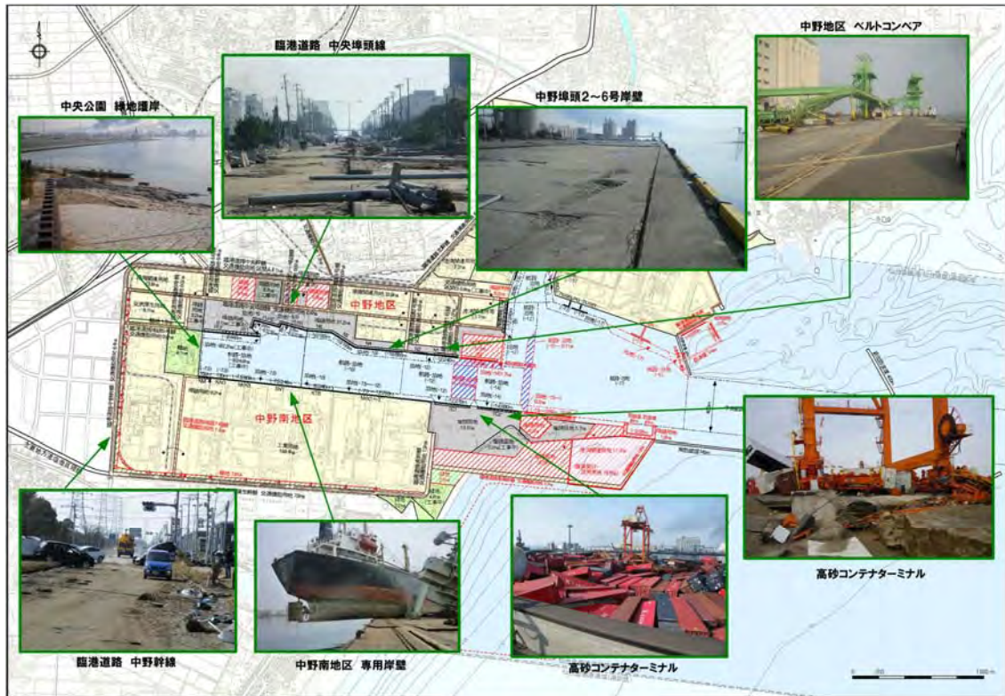
図 3-6 仙台塩釜港（仙台港区）被災状況
