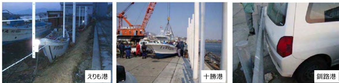
図 3-26 東北地方太平洋沖地震での津波漂流物対策の効果事例（北海道港湾）
