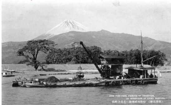
明治20年頃 蛇松にて土砂を運ぶ作業船 写真引用「古絵葉書に見る東海の富士」 (市川博康 編集・発行 2013年4月)
