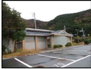
⑫ トイレ・駐車場 (西伊豆町)
