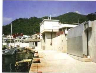
胸壁・陸閘の整備 (西伊豆町)
