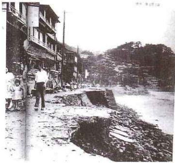
1949年8月キティ台風による 波浪被害が生じた和田磯(熱海市)
