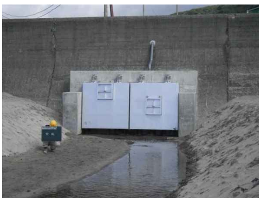
大浜川樋門のフラップゲート化
