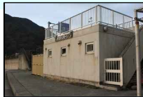
⑦ トイレ (河津町)
