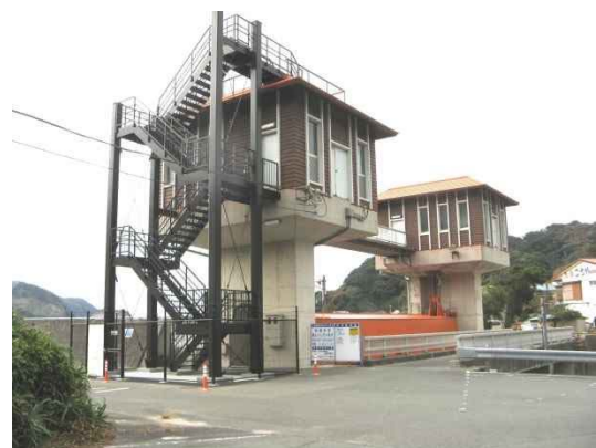
五十鈴川水門に避難用階段設置
