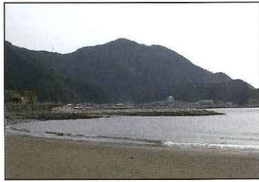
自然素材を用いた突堤整備 (西伊豆町)
