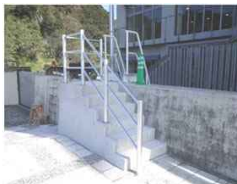
松崎港の避難階段(松崎町)
