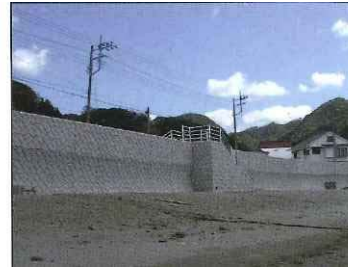
景観に配慮した護岸 (南伊豆町)
