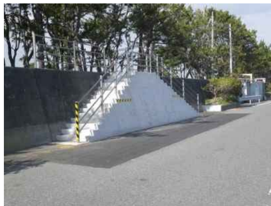
堤防の避難階段(牧之原市)
