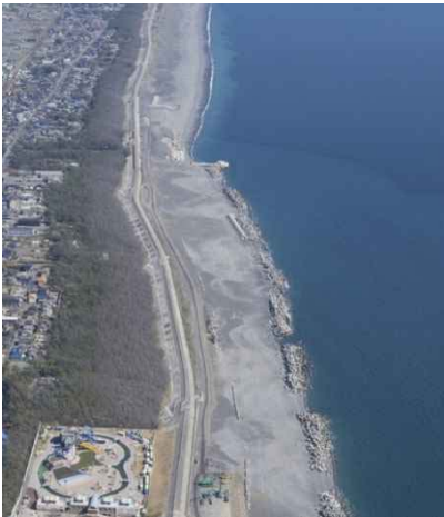
富士海岸の離岸堤や消波工
