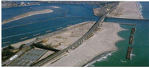
⑥ 離岸堤が設置されている浜名港海岸
