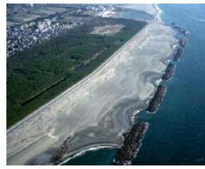
⑦ 離岸堤が設置されている浜松五島海岸
