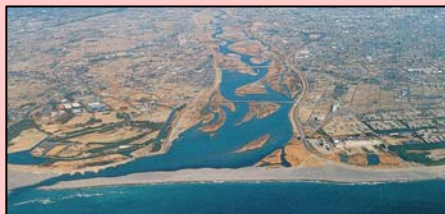
遠州灘に土砂を供給する天竜川
