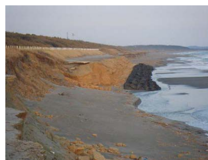
浅羽海岸での自転車道盛土部の後退
