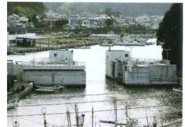
船溜前面に設置した水門 (西伊豆町)
