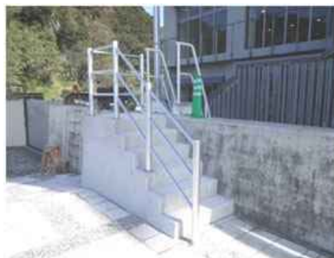
松崎港の避難階段(松崎町)
