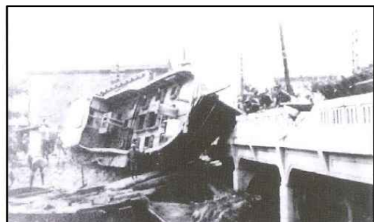
関東地震(1923 年)の津波により 伊東大川の大川橋に押し流された船(伊東市) 資料：伊東市
