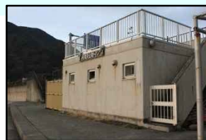
⑦ トイレ (河津町)
