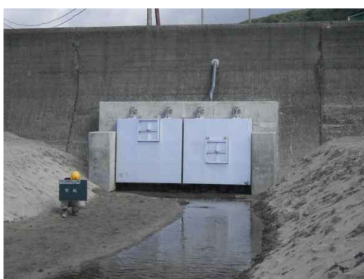
大浜川樋門のフラップゲート化
