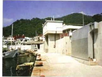
胸壁・陸閘の整備 (西伊豆町)
