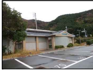
⑫ トイレ・駐車場 (西伊豆町)
