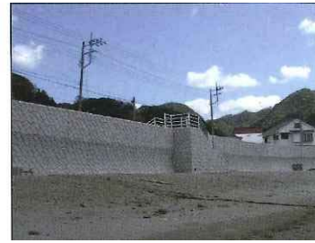
景観に配慮した護岸 (南伊豆町)
