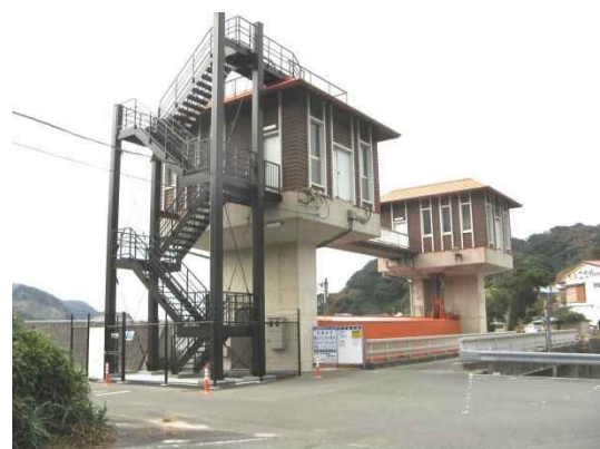
五十鈴川水門に避難用階段設置
