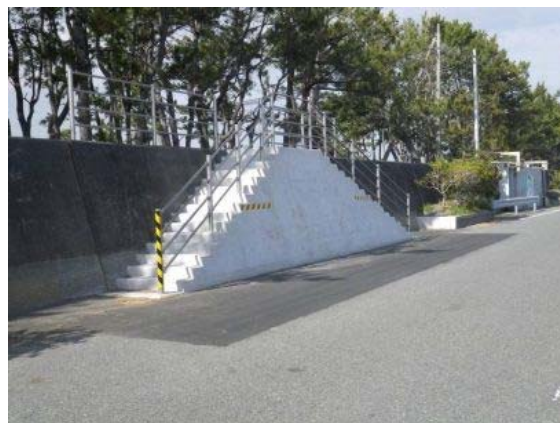
堤防の避難階段(牧之原市)
