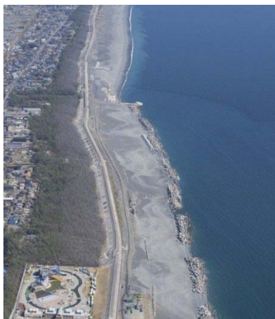
富士海岸の離岸堤や消波工
