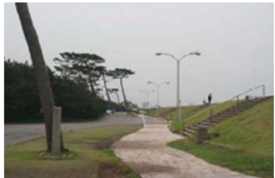
緩傾斜の盛土による護岸を施しアクセスを可能にした沼津海岸の例
