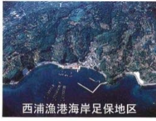
西浦漁港海岸足保地区
