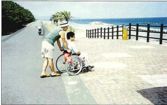
アクセスに配慮した海岸堤防 資料：静岡河川事務所
